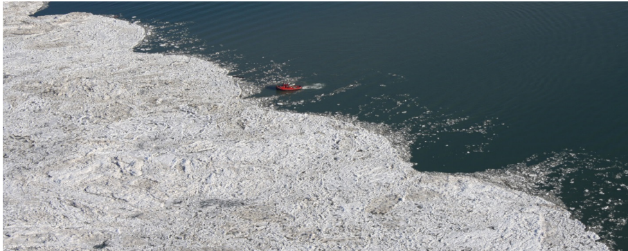
Ryc. 2. Przegroda lodowa na jeziorze Erie podczas ruszenia lodu 9 kwietnia 2009 r. widok od wschodu na przęsła R – U (Niagara Ice Flight, Gomez and Sullivan Engineers, P.C.)
